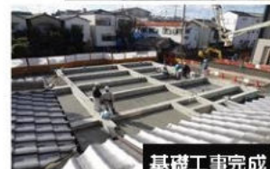
基礎工事完成
