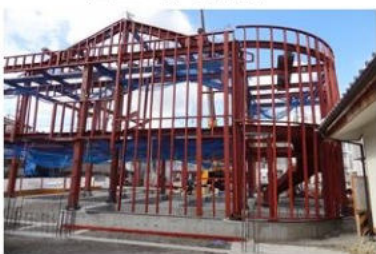
鉄骨組み立て
