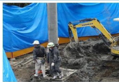
基礎工事17メートルの杭34本
