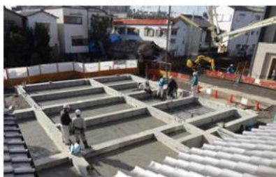
コンクリート基礎
